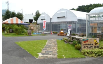
▲中央の二つが新設した売店ハウス
